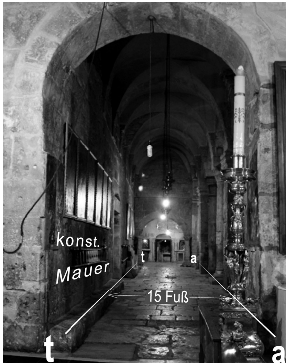
Abb.11: Blick in die ehemalige nördliche Arkade des Atriums. Die Richtung der Nordwand entspricht der konstantinischen Planung (Gerade t-t). Der Abstand zwischen Wandflucht und Säulenachse Arkade (Gerade a-a) beträgt 15 Fuß. Grundriss Abb.10 (Foto: Günther Schmidt, Wien).
