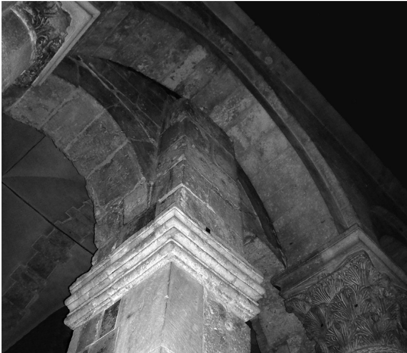
Abb.13: Divergierende Fluchten zwischen der konstantinischen Anlage (nördliche Arkade des Atriums) und jener der Kirche der Kreuzfahrer (nördliches Querschiff). Grundriss Abb.10 (Foto: Verfasser).
